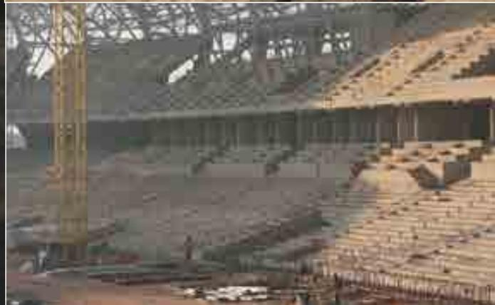
La charpente métallique représente un défi technique. L'architecte a insisté sur l'aspect de la dentelle d'acier, formant une corbeille gigantesque, d'où s'étendent des porte-à-faux pouvant atteindre 32 m de portée, couvrant ainsi l'ensemble des gradins et offrant une visibilité aux spectateurs, quelque soit leur position. Le génie des équipes structure s'exprime
